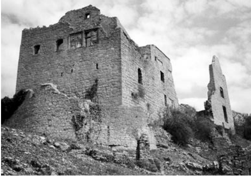
Ansicht vor der Zwingersanierung
